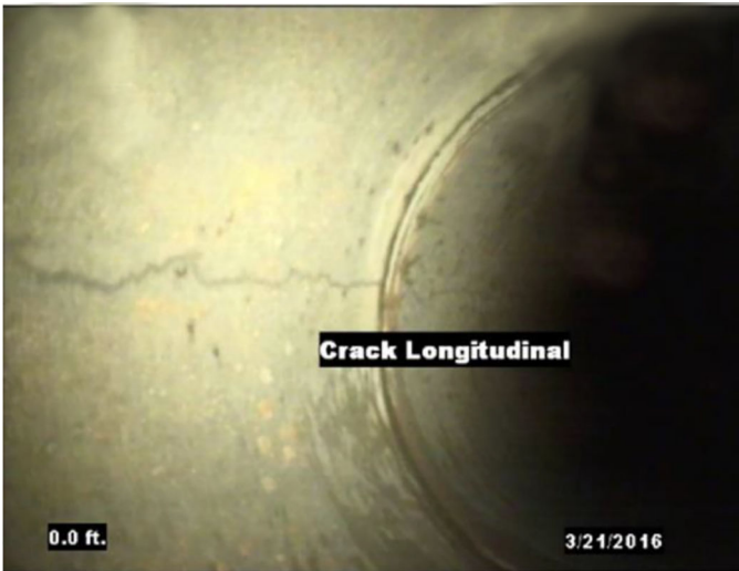
FIG. 8 Longitudinal Crack
