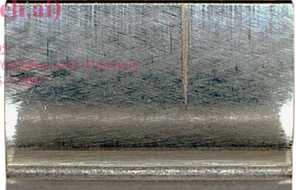
f) Traces de détérioration d'environ 2 mm
