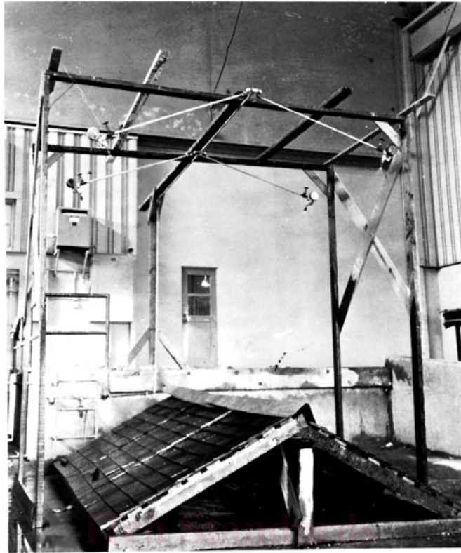
FIG. 3 Rain Test Apparatus
